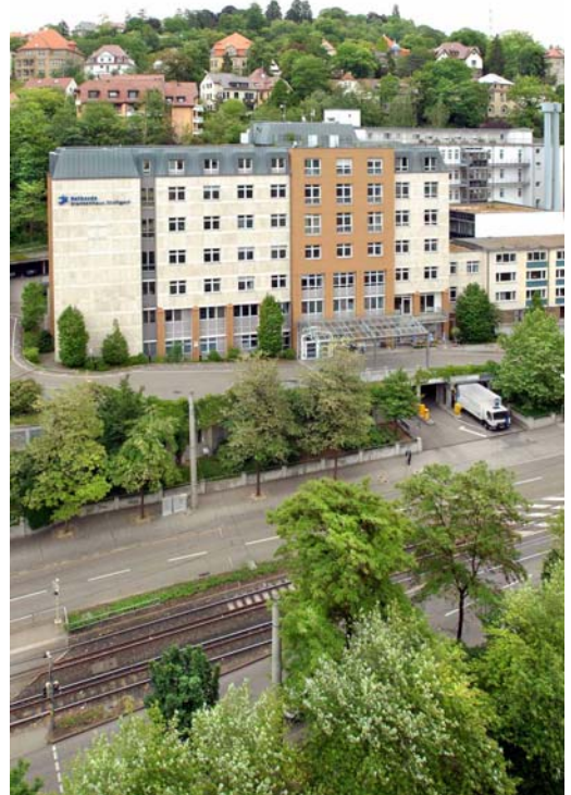
Das Foto zeigt einen Blick auf das Bethesda Krankenhaus in der Hohenheimer Straße – eine Klinik der Allgemeinversorgung mit diakonischem Profil seit über 100 Jahren am selben Standort im Herzen von Stuttgart.
